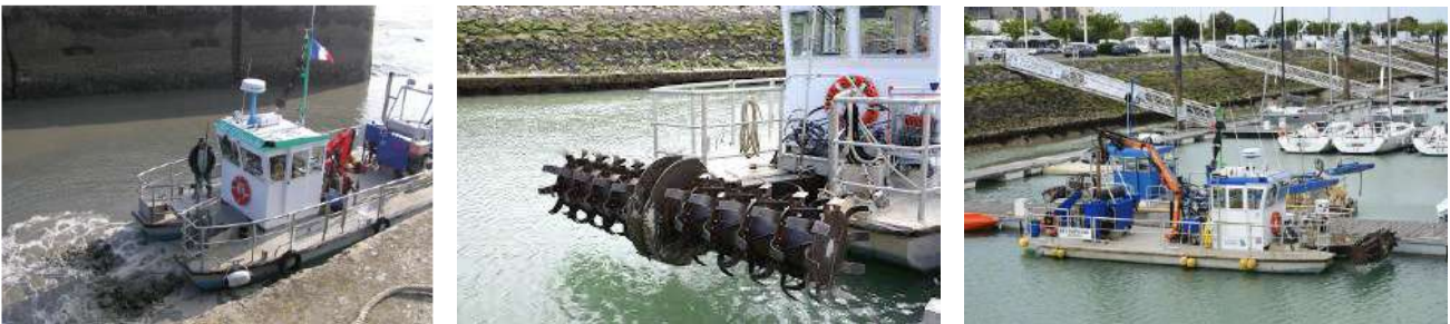
Figure 39 : Illustration de dragages par rotodévaseur dans la zone d'étude
