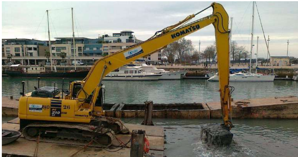
Atelier dipper : pelle mécanique sur ponton + barge
