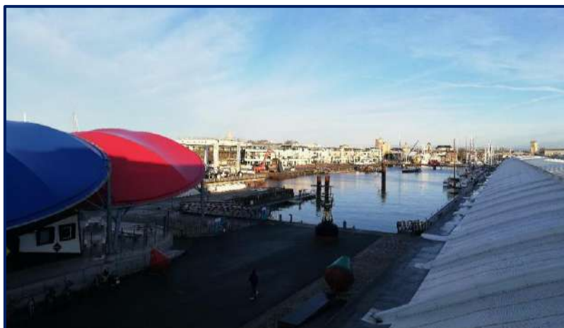
Figure 85 : Vue depuis la salle de réunion sur les opérations de dragage du bassin des Chalutiers
